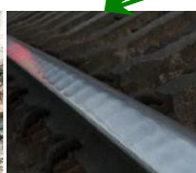
Schienenoberflächenschädigung Gerade
