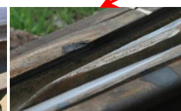
Verschleiss Weichenkomponenten
